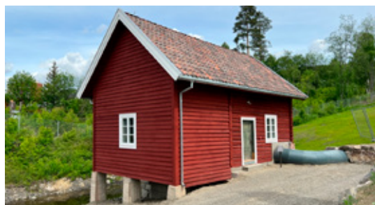
Andkvern kraftstasjon fra 1899, ferdig restaurert i sommer. Foto: Rannveig Røstad, Maihaugen
